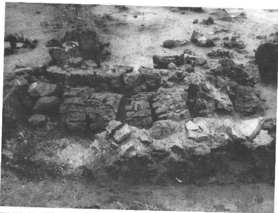
Tafel II: 3 – Wärmeofen (des Hypokaust-Typs).
