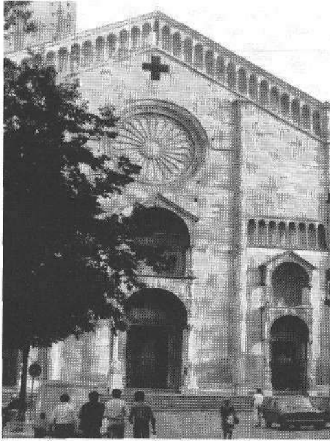
Abb. 3: Piacenza, Dom – Westseite
